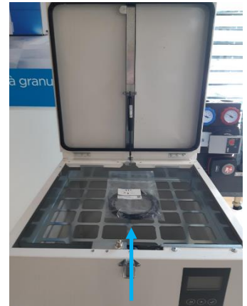
Sonde ECS à l'intérieure de la trémie de granulés
