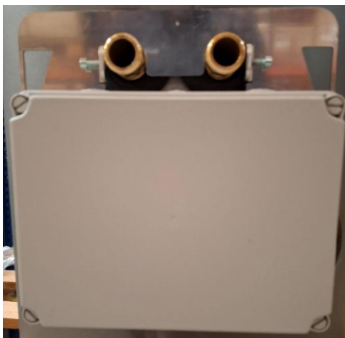
Monter l'équerre sous le collecteur
